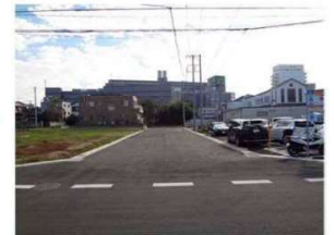
区画道路8号線築造工事 (H30) 【工事後】
