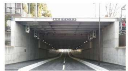
西堀水川トンネル 完成後H30年1月
