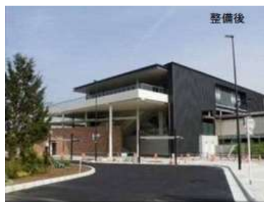
指扇駅橋上化（北口）
