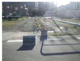
区画道路8号線築造工事 (H30) 【工事前】
