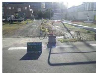
区画道路8号線築造工事 (H30) 【工事前】
