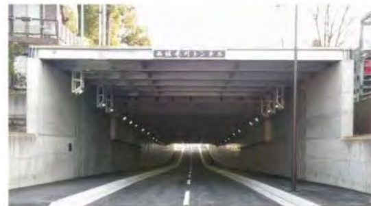
西堀氷川トンネル 完成後H30年1月
