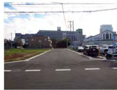
区画道路8号線築造工事 (H30) 【工事後】
