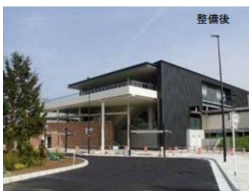
指扇駅橋上化（北口）
