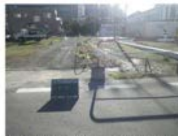
区画道路8号線築造工事 (H30) 【工事前】
