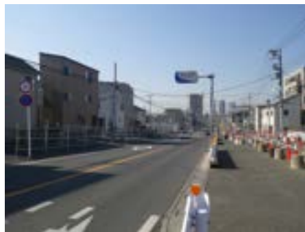
富士見坂付近の整備状況 （令和3年3月時点）
