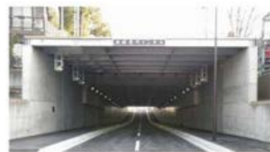
西堀氷川トンネル 完成後H30年1月
