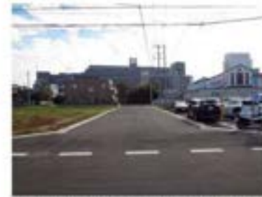
区画道路8号線築造工事 (H30) 【工事後】
