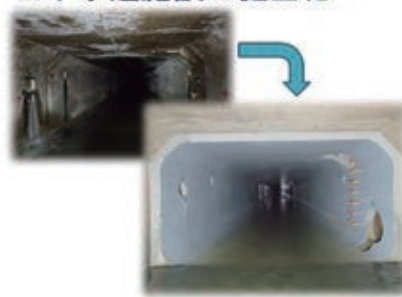
老朽化した下水道管の改築
