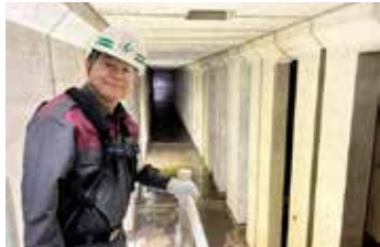
岩槻諏訪公園の雨水貯留施設を視察
